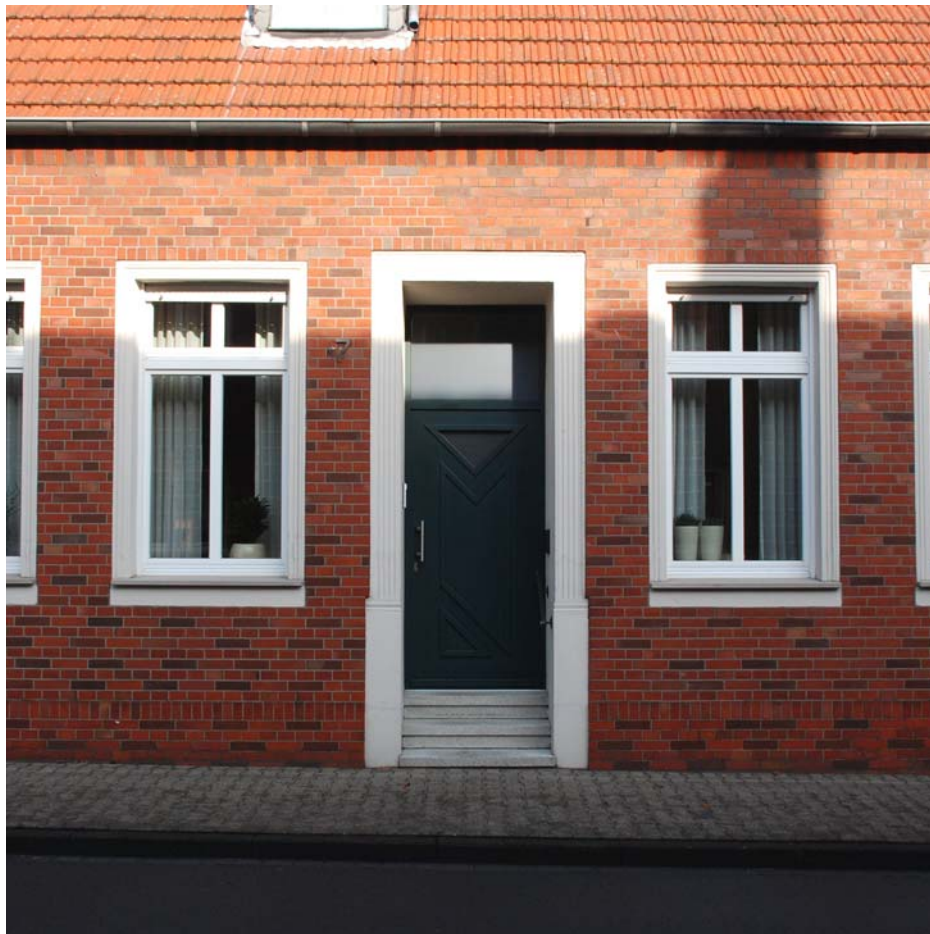
Typische Tür- und Fensterformate in der Ortsmitte
